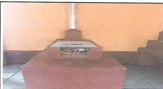
Foto 4: INSTALACIÓN DE ESTUFA RURAL CON CHIMINEA
