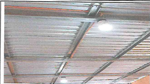
Foto 8: INSTALACIÓN DE UNIDADES DE LUZ
