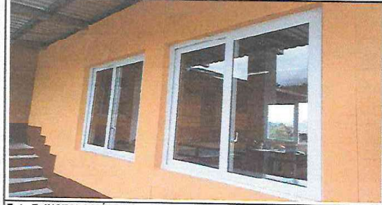
Foto 7: INSTALACIÓN DE VENTANA PVC
