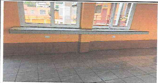
Foto 12: INSTALACIÓN DE CERAMICA EN MESONES DE CONCRETO
