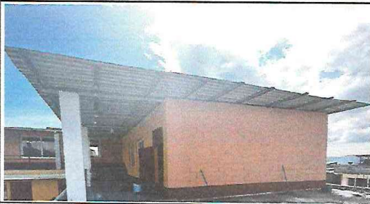
Foto 1: MUROS PERIMETRALES DE COCINA
