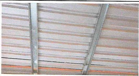
Foto 3: INSTALACIÓN DE LAMINA TROQUELADA ALUZINC
