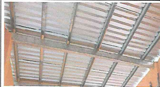
Foto 2: INSTALACIÓN DE ESTRUCTURA PORTANTE DE METAL
