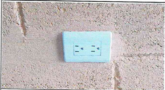
Foto 9: INSTALACIÓN DE UNIDADES DE FUERZA
