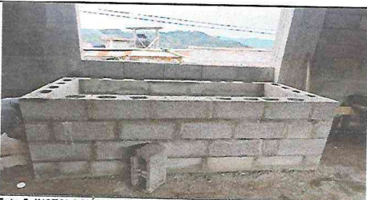
Foto 5: INSTALACIÓN DE MESA DE CONCRETO CON UN LAVADERO
