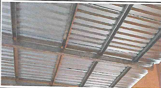
Foto 3: INSTALACIÓN DE LAMINA TROQUELADA ALUZINC
