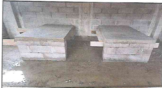
Foto 4: INSTALACIÓN DE ESTUFA RURAL CON CHIMINEA
