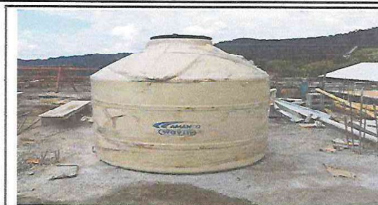
Foto 14: SUSTITUCIÓN DE DEPÓSITO DE AGUA DE 1700 LT
