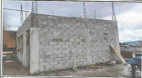
Foto 1: MUROS PERIMETRALES DE COCINA
