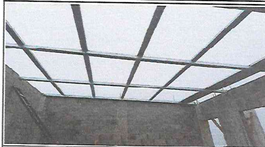
Foto 2: INSTALACIÓN DE ESTRUCTURA PORTANTE DE METAL
