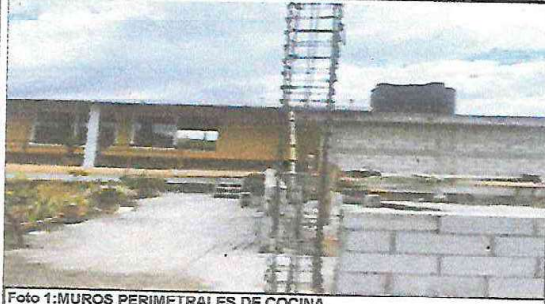
Foto 1: MUROS PERIMETRALES DE COCINA
