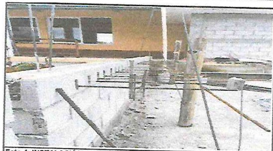
Foto 4: INSTALACIÓN DE MESA DE CONCRETO
