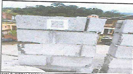
Foto 9: INSTALACION DE ACOMETIDA ELÉCTRICA
