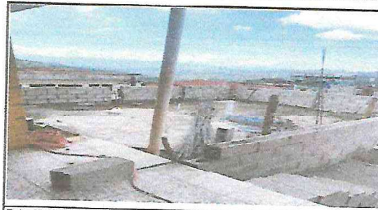
Foto 10: INSTALACIÓN DE PISO CERAMICO
