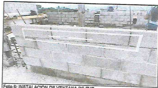
Foto 6: INSTALACIÓN DE VENTANA DE PVC
