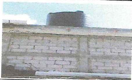
Foto 11: SUSTITUCIÓN DE DEPOSITO DE AGUA 1700 LT
