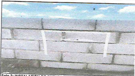
Foto 3: INSTALACIÓN DE ESTUFA RURAL CON CHIMENEA
