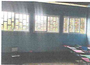
Foto 3.1 Instalación de ventanas PVC de 1 x 1.40
