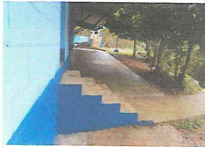
Foto 3.2 Mejoramiento de patio con pavimento
