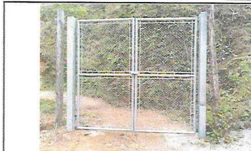
Foto 5.1 Instalar puerta con malla metalica de 2x1
