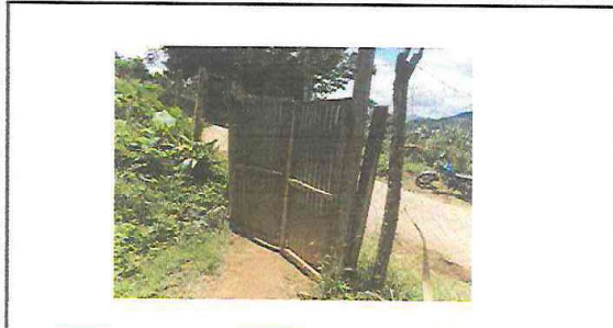
Foto 5.1 Instalar puerta con malla metalica de 2x1
