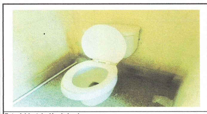
Foto 4.1 Instalación de inodoros
