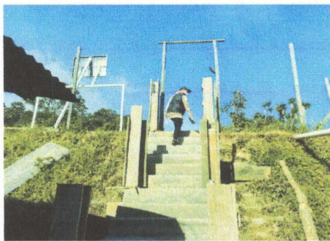
Foto 1.3 Barandal con tubo redondo galvanizado
