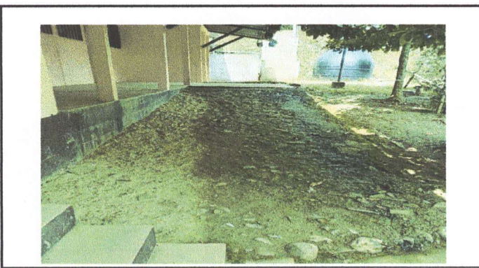
Foto 3.2 Mejoramiento de patio con pavimento
