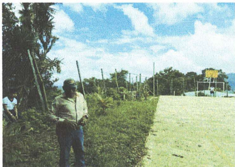
Foto 1.1 Sustitucion de maya por malla ciclonica de 4 m de alto con tubo galvanizado
