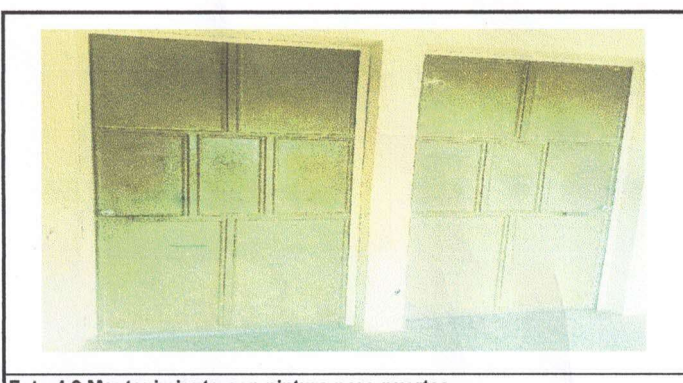
Foto 4.2 Mantenimiento con pintura para puertas
