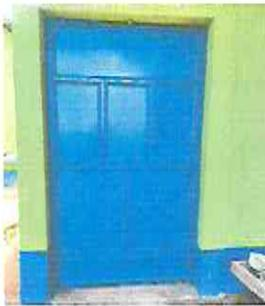
Foto 9: Mantenimiento de puertas, cocina, módulo 1.2.3 lijar, limpiar y pintar
