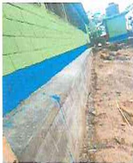
Foto 11: Protección a cimiento patio parte trasera con block fundido
