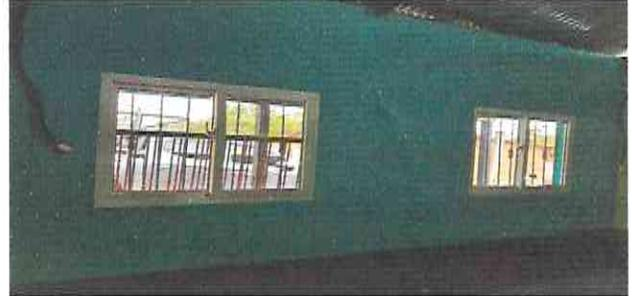
Foto 2: Sustitución de estructura de metal de ventana
