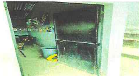
FOTO 4: Sustitución de puerta
