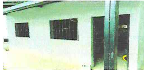
FOTO 2: Sustitución de estructura de metal de ventana
