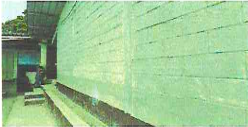
FOTO 1: Pintura en muros exteriores e interiores
