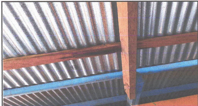
Foto 2.1 Sustitución de estructura de soporte de madera por metal.
