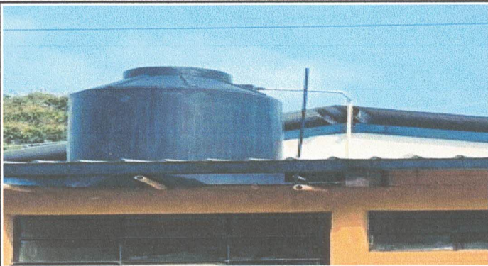
Foto 7.1 Sustitución de depósito de agua de (1,100 litros)
