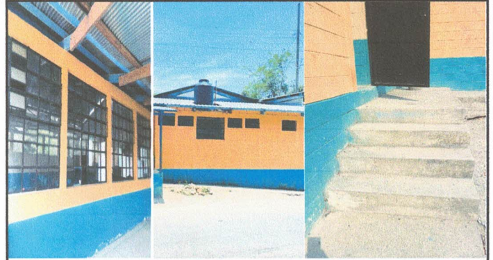
Foto 8.1 Fabricación e instalación de balcones de hierro en ventanas. Foto 8.2 Fabricación e instalación de porton de metal de ingreso de 2.6 M2.
