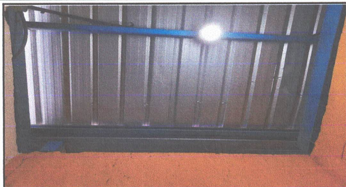
Foto 1.1 Sustitución de lámina troquelada Aluzinc calibre 26.
