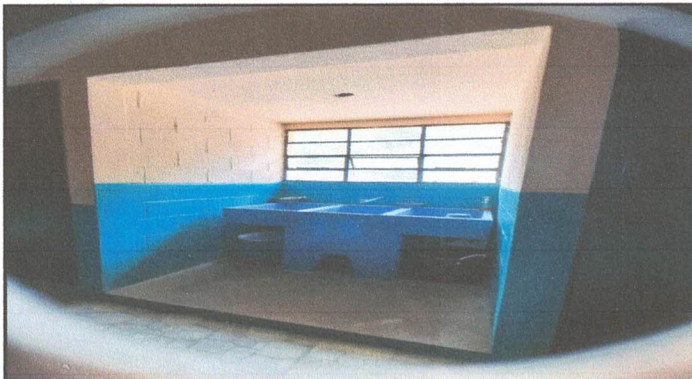
Foto 9.1 Sustitución de pila de dos lavaderos.
