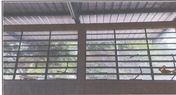
Foto 4.1 Sustitución e instalación de ventanas de PVC de módulo 1 (1.10 x 15.27)
