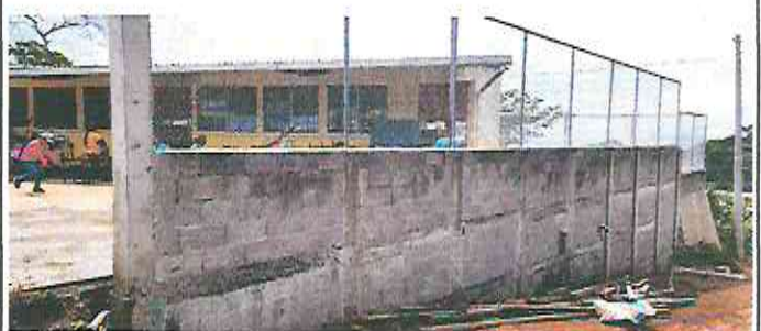
FOTO 4: REPARACION DE MURO PERIMETRAL DE BLOCK
