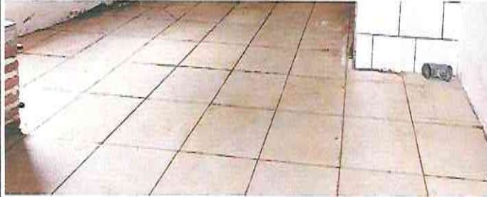
FOTO 1: SUSTITUCION PISO CERAMICO
