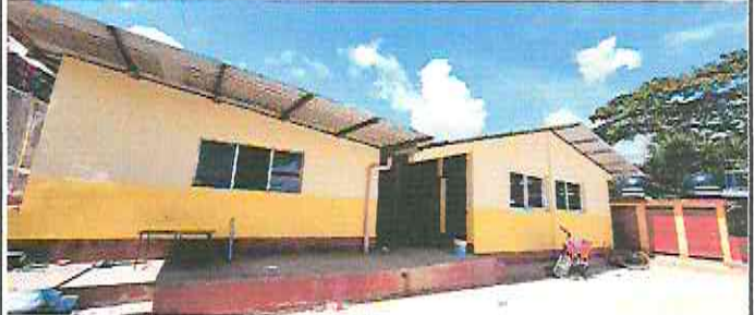
FOTO 2: PINTURA EN MUROS INTERIORES Y EXTERIORES
