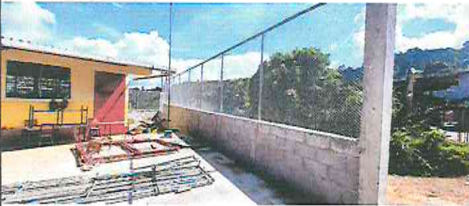
FOTO 3: REPARACION DE MURO PERIMETRAL DE BLOCK
