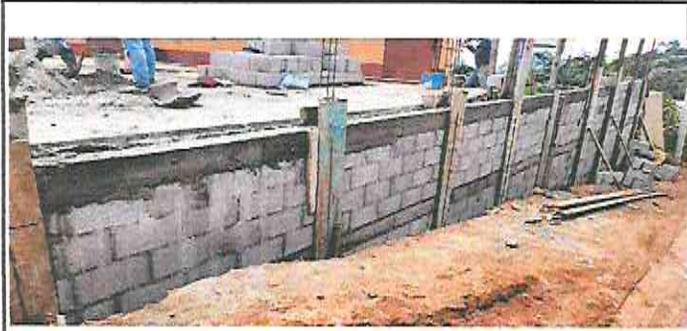
FOTO 3: REPARACION DE MURO PERIMETRAL DE BLOCK
