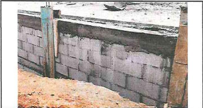
FOTO 4: REPARACION DE MURO PERIMETRAL DE BLOCK
