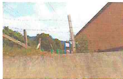
FOTO 6: REPARACION DE TUBO HG Y MALLA GALVANIZADA
