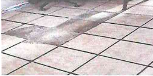
FOTO 1: SUSTITUCION PISO CERAMICO
