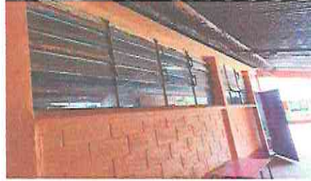
FOTO 2: PINTURA EN MUROS INTERIORES Y EXTERIORES
