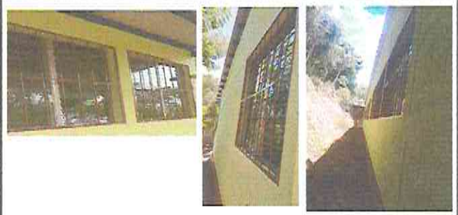
Foto 2: mantenimiento de balcones de metal.
