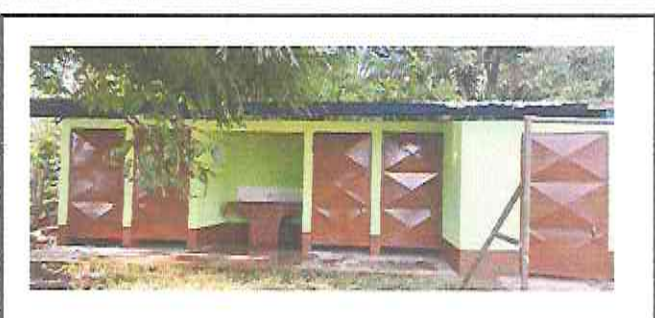
Foto 6: mantenimiento de estructura. (lijado, cambio de tubo, cepillado, sujeción, aplicación de pintura) en puertas, pintar muros interiores y exteriores de los sanitarios.
