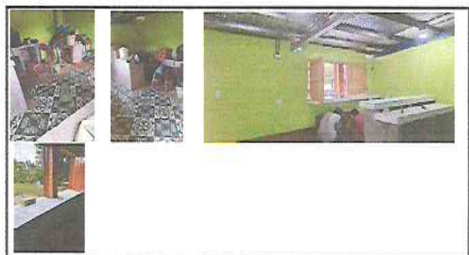
Foto 4: Instalación de azulejo en estufa, muebles de cocina, sustitución de piso cerámico, sustitución de lamparas tipo led, sustitución de plafoneras, sustitución de interruptores simples, sustitución de tomacorrientes.
