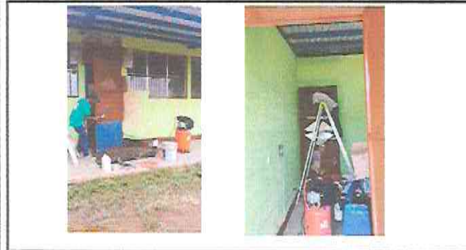
Foto1: mantenimiento. (lijado, cambio de tubo, cepillado, sujeción, aplicación de pintura) en puertas, Sustitución de vidrios (percianas).
