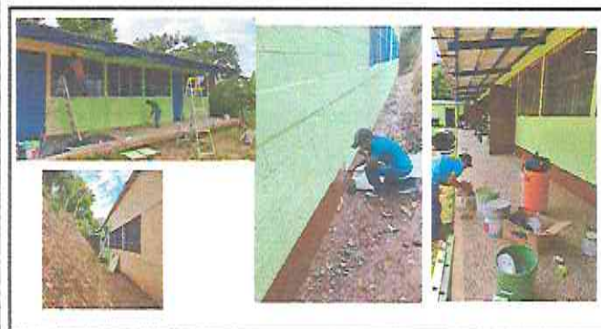
Foto 3: pintar aulas interior y exterior.
