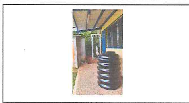
Foto 5: suministro de estructura metalica para deposito de agua 3 metros de alto, suministro de instalación de tanque de agua para almacenamiento de agua de 760lt.
