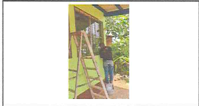
Foto 2: mantenimiento de balcones de metal.
