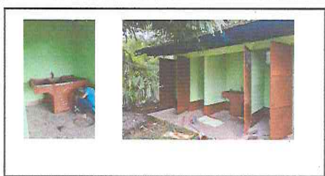
Foto 6: mantenimiento de estructura. (lijado, cambio de tubo, cepillado, sujeción, aplicación de pintura) en puertas, pintar muros interiores y exteriores de los sanitarios.
