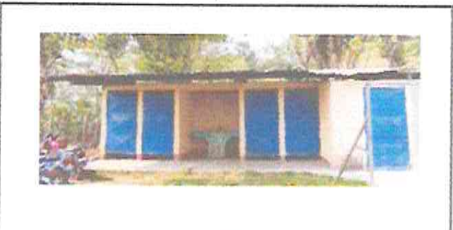
Foto 6: mantenimiento de estructura. (lijado, cambio de tubo, cepillado, sujeción, aplicación de pintura) en puerta, pintar muros interior y exteriores de los sanitarios.
