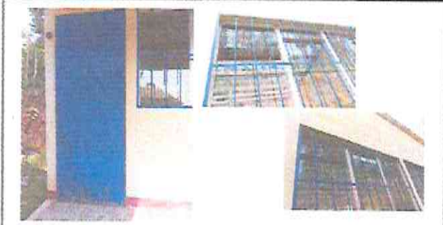
Foto 1: mantenimiento de estructura. (lijado, cambio de tubo, cepillado, sujeción, aplicación de pintura) en puertas. Sustitución de vidrios (percianas).
