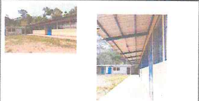
Foto 3: pintar aulas interior y exterior.
