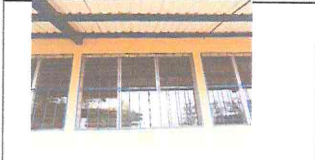
Foto 2: mantenimiento de balcones de metal.
