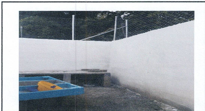
Foto1: Reparación de muro perimetral de Block y sernido en muro
