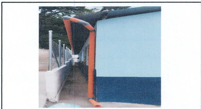
Foto 3: Cernido en muro perimetral y reparación de muro con tubo HG y malla galvanizada.
