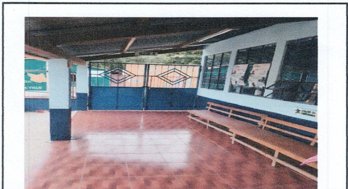
Foto 2 Sustitución de portón de metal de ingreso.
