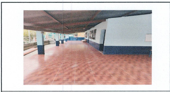
Foto 5: Sustitución de piso de cemento líquido por piso cerámico
