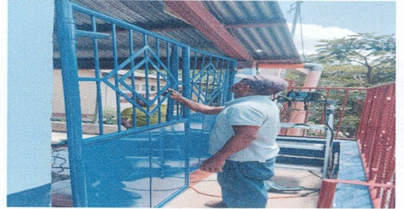
Foto 2: Sustitución de portón de metal de ingreso.
