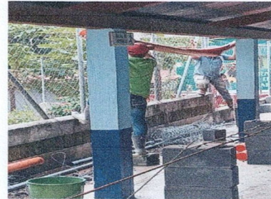
Foto 4: Sustitución de canal de PVC.
