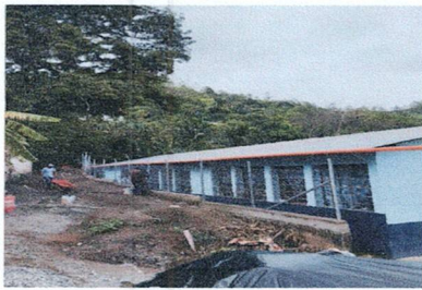
Foto 3: Cernido en muro perimetral y reparación de muro con tubo HG y malla galvanizada.
