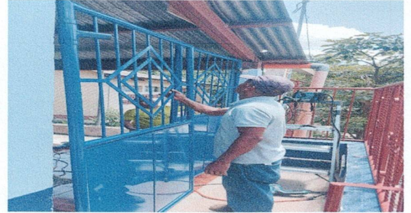
Foto 2: Sustitución de portón de metal de ingreso.
