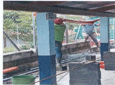
Foto 4: Sustitución de canal de PVC.
