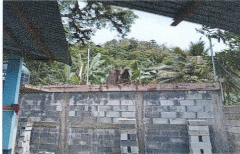
Foto 1: Reparación de muro perimetral de Block y sernido en muro
