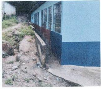
**Reparación de muro perimetral de block con tubo hg y malla galvanizada**
