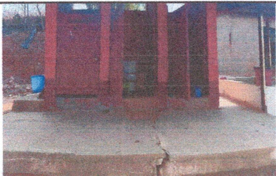
Foto 5: Reparación de Sistema de tratamiento septico existente en mal estado.
