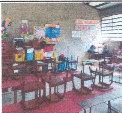
Foto 1: Reparación de 2 Aulas, Cocina y Corredor con Piso Ceramico. (AULA).
