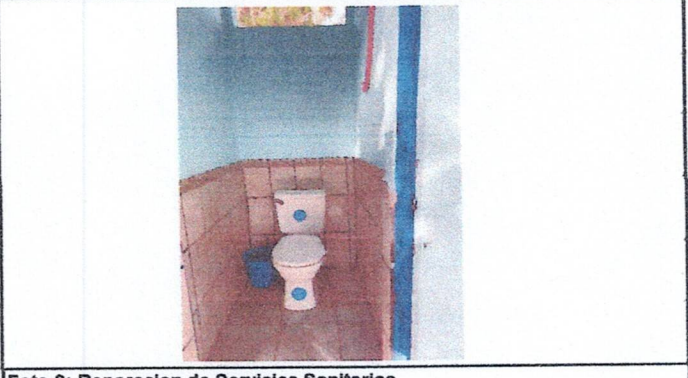
Foto 2: Reparacion de Servicios Sanitarios
