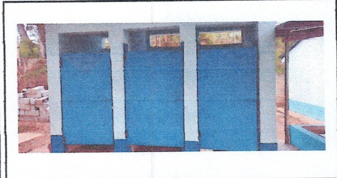
Foto 3: Reparacion de Servicios Sanitarios
