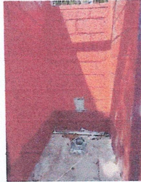
Foto 2: Reparacion de Servicios Sanitarios
