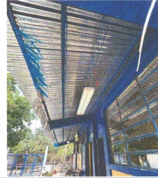
Foto 2: Reparación Sistema Eléctrico, flaponera, foco, flexitubo, abrazaderas, cables, tomacorrientes e interruptores.
