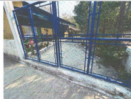
Foto 6: Mantenimiento a Porton
