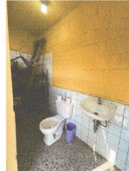
Foto 4: Reparación de Servicios Sanitarios para niños y niñas y Reparación Sistema Eléctrico, flaponera, foco, flexitubo, abrazaderas, cables, tomacorrientes e interruptores.
