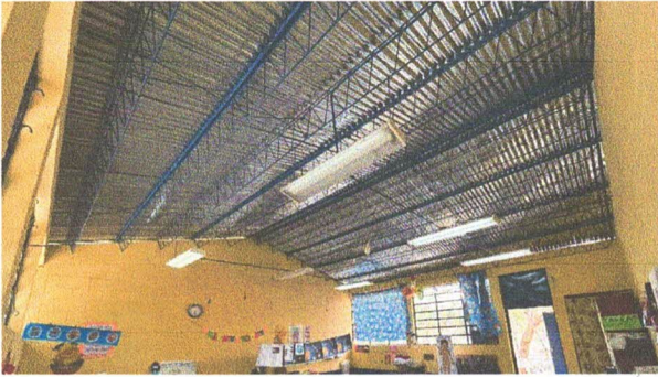
Foto 1: Reparación Sistema Eléctrico, flaponera, foco, flexitubo, abrazaderas, cables, tomacorrientes e interruptores.
