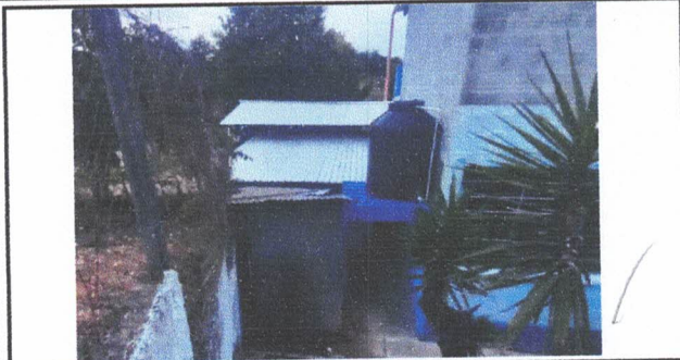
Foto 7: Desmontaje de Torre y Deposito de Agua Potable.
