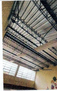
Foto 2: Techo del aula
