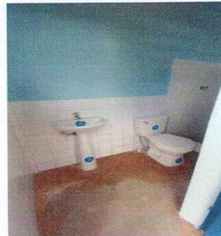
Foto 6: Terminación, servicios sanitarios, cambio de taza de inodoro, lavamanos, cambio de flote a deposito de agua y mantenimiento de puertas metalicas.
