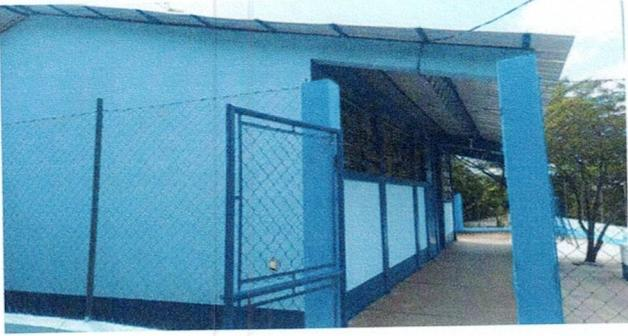
Foto1: Terminación de 2 aulas y corredor de Escuela de parvulos. Cambio de lamina de asbesto cemento a lamina troquelada de aluzinc calibre 26 legitimo.
