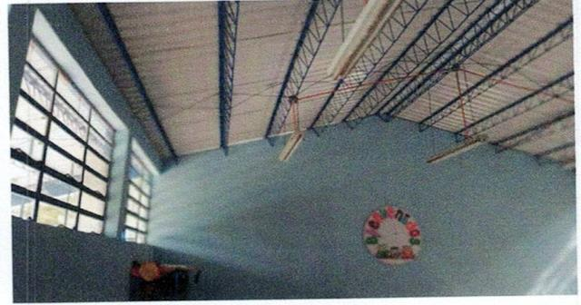
Foto 2: Terminación de 2 aulas y corredor de Escuela de parvulos. Cambio de lamina de asbesto cemento a lamina troquelada de aluzinc calibre 26 legitimo.
