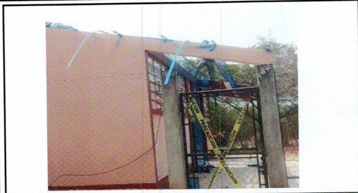
Foto 1: Proceso de 2 aulas y corredor de la escuela de Parvulos. Quitado de lamina de Asbesto cemento a la mina Troquelada de Aluzinc calibre 26 legitimo.
