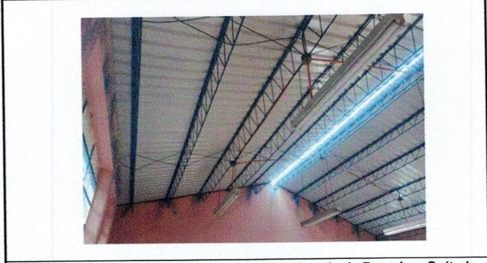
Foto 2: Proceso de 2 aulas y corredor de la escuela de Parvulos. Quitado de lamina de Asbesto cemento a la mina Troquelada de Aluzinc calibre 26 legitimo.
