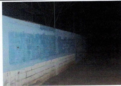
Foto 10: Proceso de muro perimetral , aplicación de pintura para interior y exterior.
