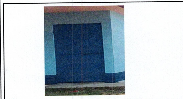
Foto 3: Proceso de 2 aulas y corredor de Escuela de Parvulos. Mantenimiento de puertas de aulas.
