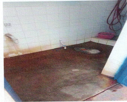
Foto 8: Proceso de servicios sanitarios, cambio de sanitario y lavamanos.
