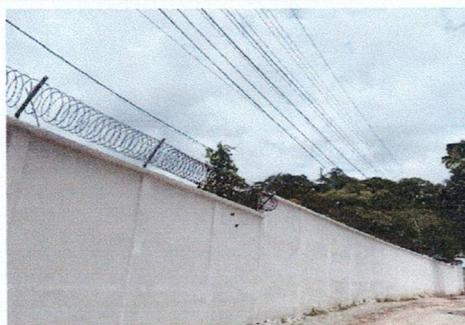
Foto 2: Reparación de muro perimetral de block. (repello)
