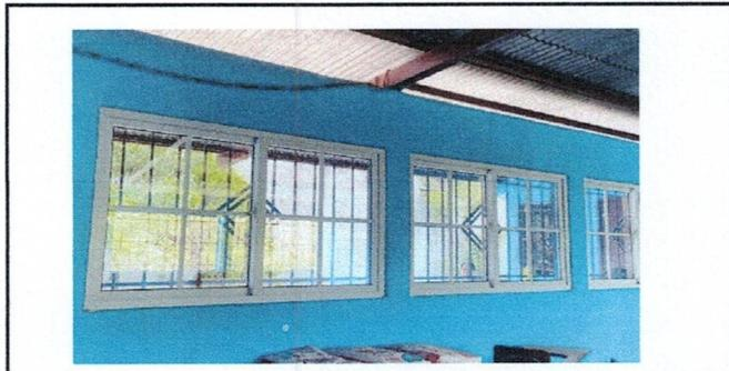
Foto 5: SUSTITUCIÓN O INSTALCIÓN DE VENTANAS DE MADERA POR PVC
