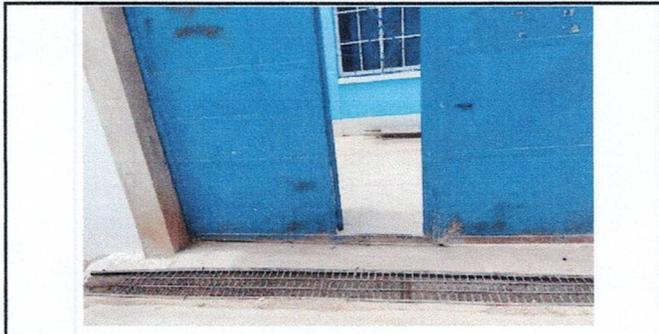
Foto 6: Reparación de cuneta de concreto
