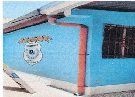
Foto 4: Sustitución de bajada de agua pluvial de metal por tubo PVC 3"
