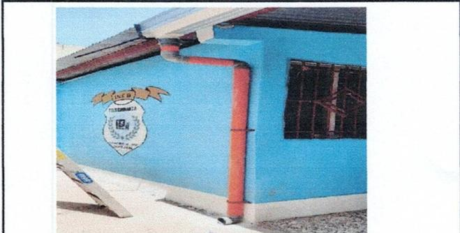
Foto 4: Sustitución de bajada de agua pluvial de metal por tubo PVC 3"
