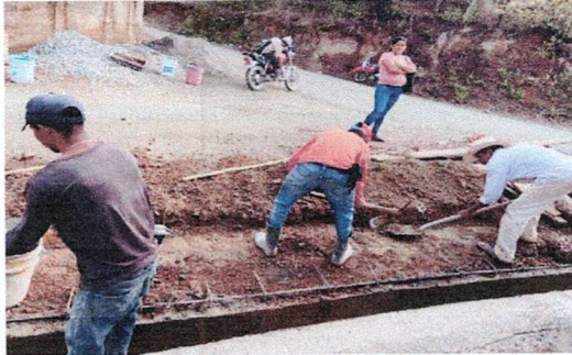
Foto7: Reparación de cuneta de concreto
