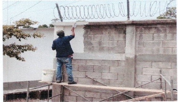
Foto 2: Reparación de muro perimetral de block. (repello)
