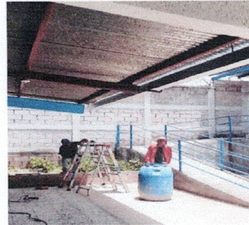
Foto 4: Sustitución de bajada de agua pluvial de metal por tubo PVC 3"
