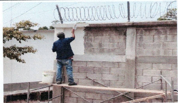
Foto 2: Reparación de muro perimetral de block. (repello)
