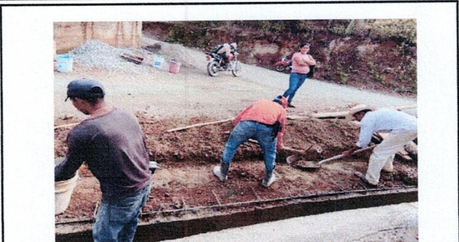
Foto7: Reparación de cuneta de concreto
