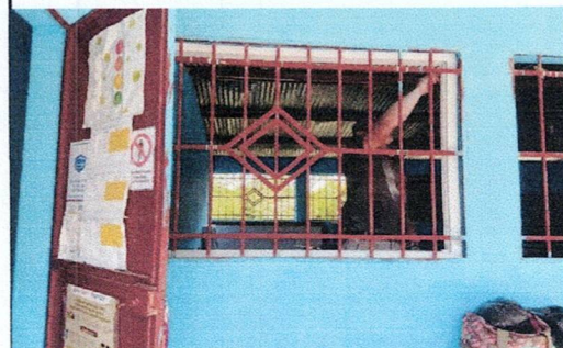
Foto 6: SUSTITUCIÓN O INSTALCIÓN DE VENTANAS DE MADERA POR PVC
