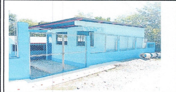
Foto1: Reparación de Cuneta y acceso peatonal, Pintura en muro exterior.
