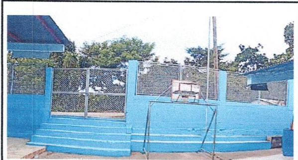
Foto 2: Instalación de Malla en marco sobre la parte frontal del muro perimetral, Sustitución de porton, aplicación de pintura en malla y porton, Pintura de muros interiores y gradas.
