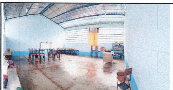
Foto 6: Pintura en las paredes interiores del aula, sustitución de ventanales dañados, cambio de sistema eléctrico.
