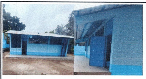
Foto 4: Mejoramiento de sistema eléctrico, mantenimiento de puertas y pintura en el exterior del aula.
