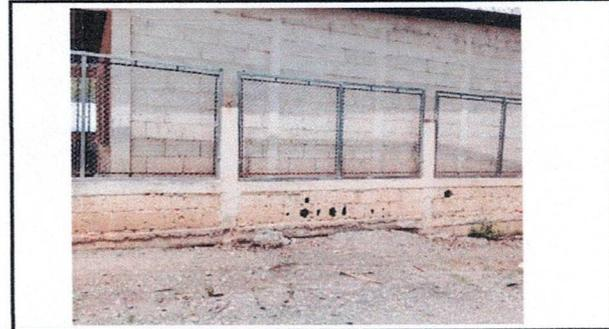
Foto 2: Instalación de Malla en marco sobre la parte frontal del muro perimetral.
