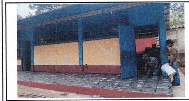
Foto 5: Proceso de Reparación de piso Cerámico en corredor.
