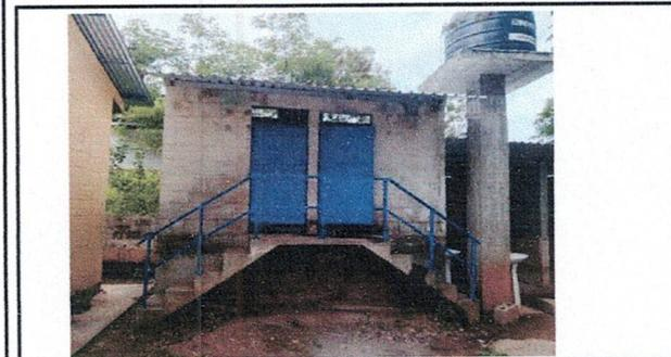
Foto 3: Reparación de barandal metálica, remoción o aplicación de pintura de aceite en barandal, cambio de techo, mantenimiento de puertas de servicios sanitarios.
