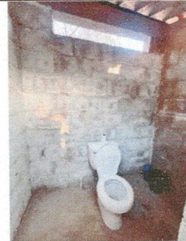
Foto 4: Reparación de Servicios Sanitarios.
