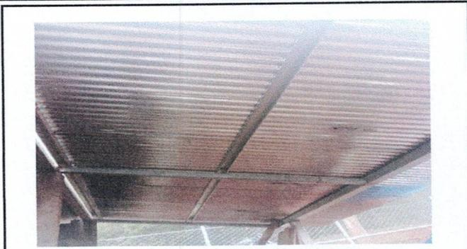
Foto1: Sustitución de lámina de galera exterior
