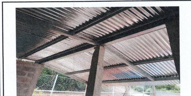
Foto 3: Sustitución de estructura de soporte de madera por estructura de soporte de metal
