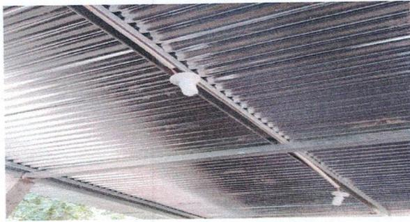
Foto7: Instalación de cableado eléctrico y bombillas
