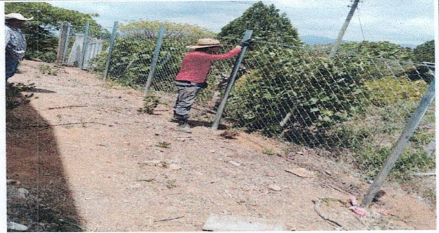
Foto 14: Instalación de malla galvanizada
