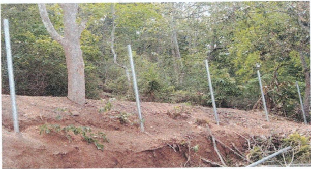
Foto13: Instalación de tubos hg, del muro perimetral
