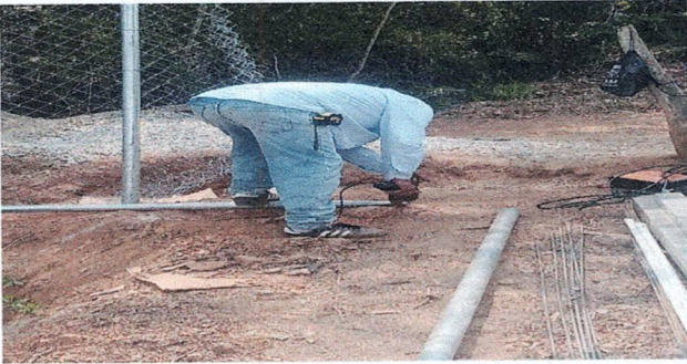
Foto 15: Soldando malla galvanizada al tubo hg
