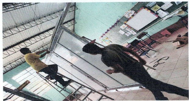
Foto 17: Instalación de división de aula
