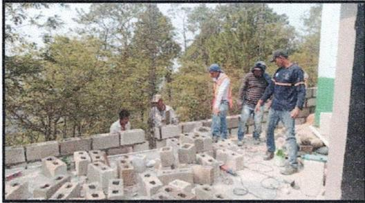
Foto1: Reparación de muro perimetral de block
