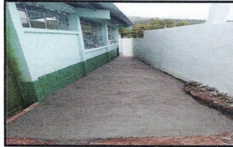
Foto 4: Reparación de banquetas de concreto
