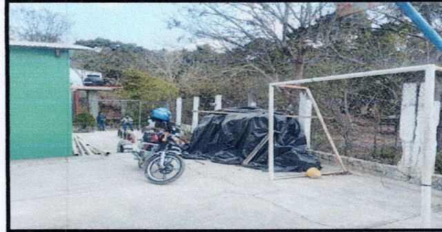
Foto 4: Reparación de losa de concreto en patio
