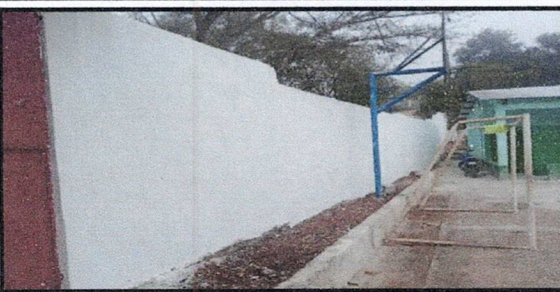
Foto 5: Reparación de banquetas
