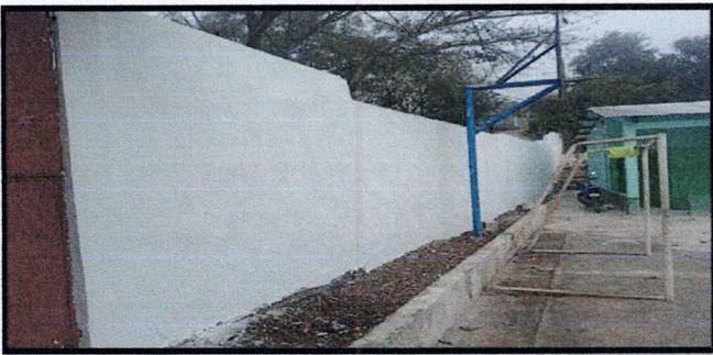
Foto 5: Reparación de banquetas de concreto
