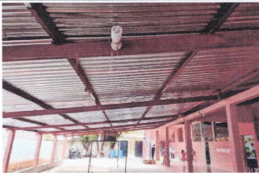
Foto 9: Sustitución de lámina en mini cancha
