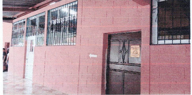
Foto 2: Instalación de ventanas en aula 3
