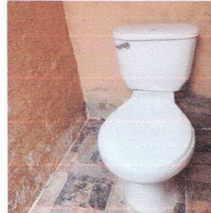
Foto 12: Instalación de baños
