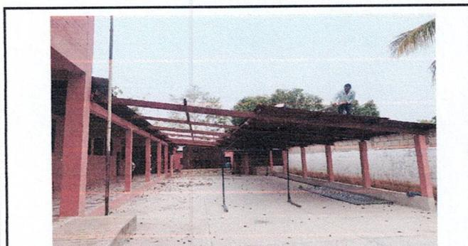
Foto 9: Sustrucción de lámina en mini cancha
