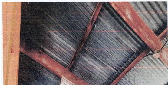
Foto 6: Sustitución de lámina en cocina
