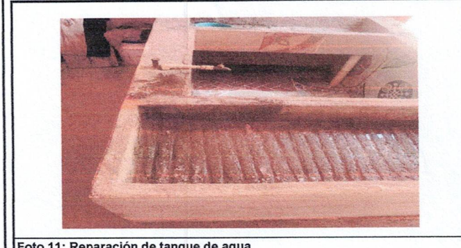
Foto 11: Reparación de tanque de agua
