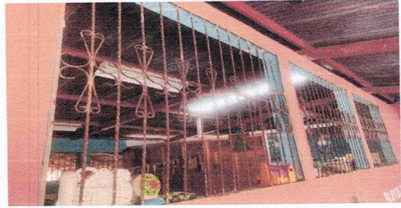
Foto 2: Instación de ventanas en aula 3
