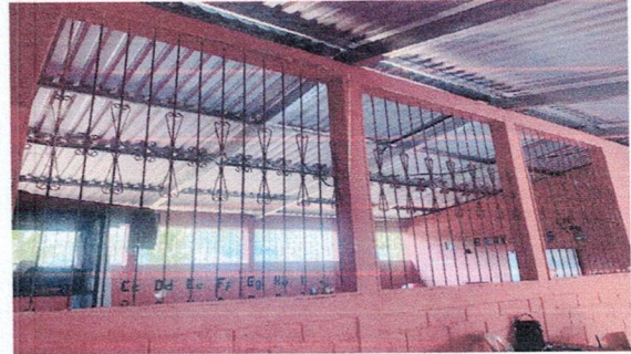
Foto 4: Instación de Ventanas en aula 5
