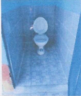
Foto 7: INTALACION DE PISO, AZULEJO Y SANITARIO EN BAÑOS.
