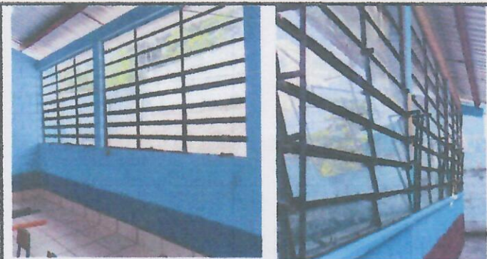
Foto 3: SUSTITUCION DE VIDRIOS.
