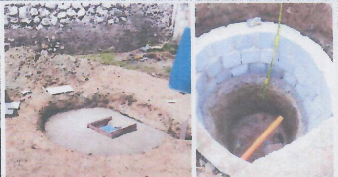
Foto 10: CREACION DE POZO DE ABSORCIÓN CON BROCAL Y TAPADERA.
