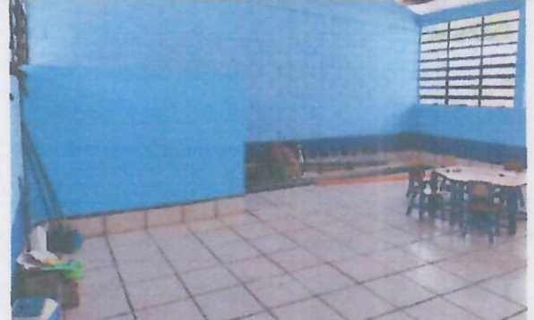
Foto 2: INSTALACION DE PISO CERAMICO.
