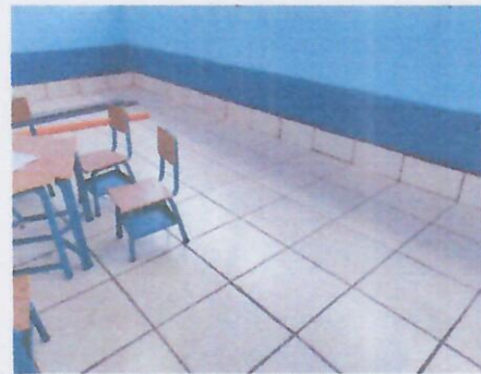
Foto 12: INSTALACION DE ZOCALO EN AULA.
