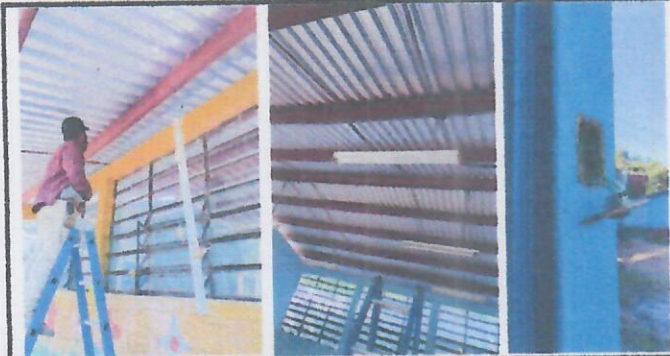
Foto 6: SUSTITUCION DE LAMPARAS.
