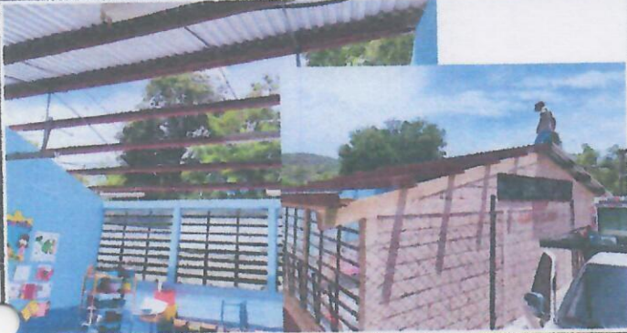
Foto 1: SUSTITUCION O INTALACION DE LAMINA TROQUELADA ALUZINC CAL. 26
