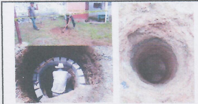
Foto 9: FABRICACION DE BROCAL Y APERTURA DE POZO.
