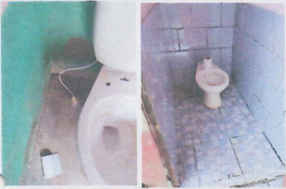
Foto 13: SUSTITUCION DE INODOROS.
