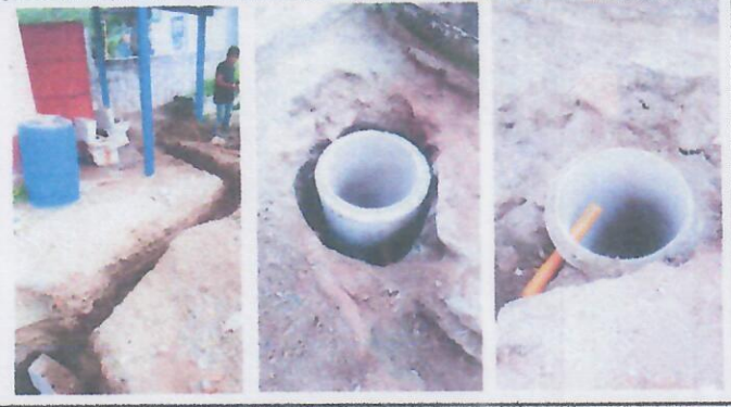
Foto 8: INTALACION DE TUBERIA HACIA NUEVO POZO DE ABSORCION DESDE NUEVA TRAMPA GRASA PARA DRENAJE DE PILA.
