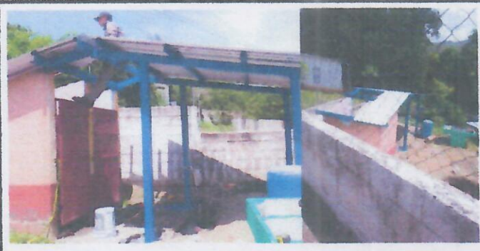
Foto 12: INSTALACION DE LAMINA TROQUELADA EN AREA DE BAÑOS Y PILA SOBRE ESTRUCTURA Y COLUMNAS METALICA NUEVA.
