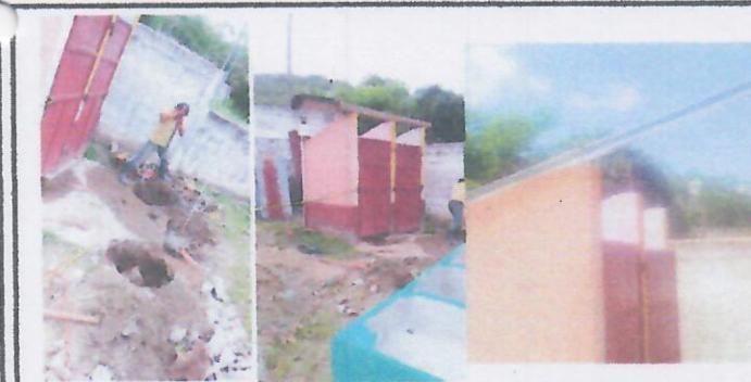
Foto 11: SUSTITUCION E INSTALACION DE ESTRUCTURA METALICA PARA TECHOS CON LAMINA TROQUELADA PARA AREA DE PILA Y BAÑO Y COLUMNAS METALICAS.
