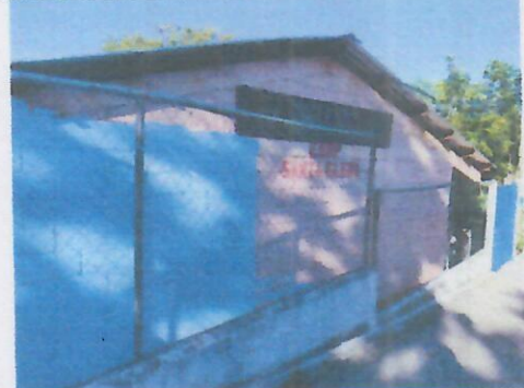
Foto 4: APLICACIÓN PINTURA EN MUROS EXTERIORES.
