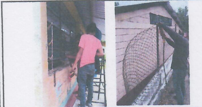
Foto 3: SUSTITUCIÓN DE VIDRIOS Y DE MALLA Y TUBO HG PERIMETRAL.
