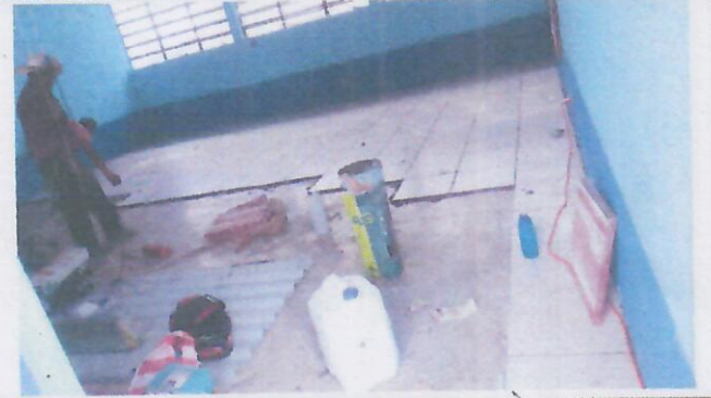
Foto 2: INSTALACION DE PISO CERAMICO.
