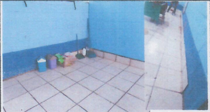
Foto 14: INTALACION DE ZOCALO EN AULA.
