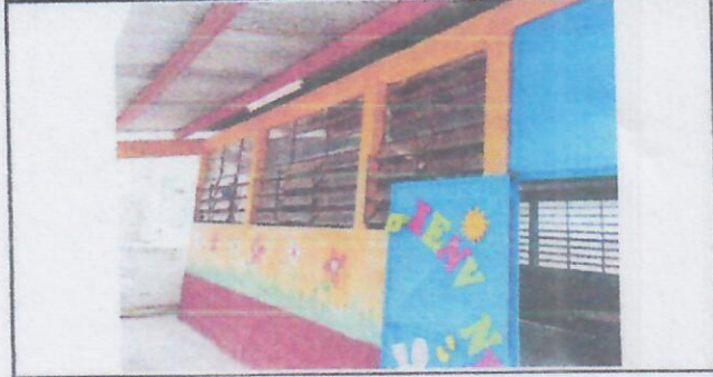
Foto 2: Sustitución de lamina en aulas.
