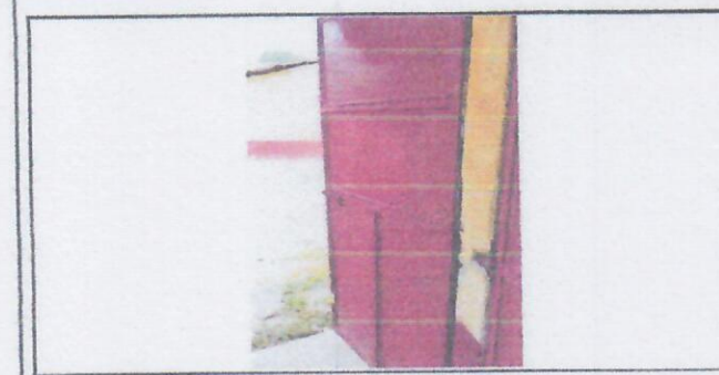
Foto 5: puertas que se les darán mantenimiento.
