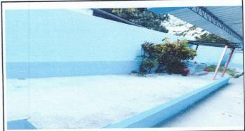
Foto 2: Reparación de muro perimetral con tabique en la parte superior.
