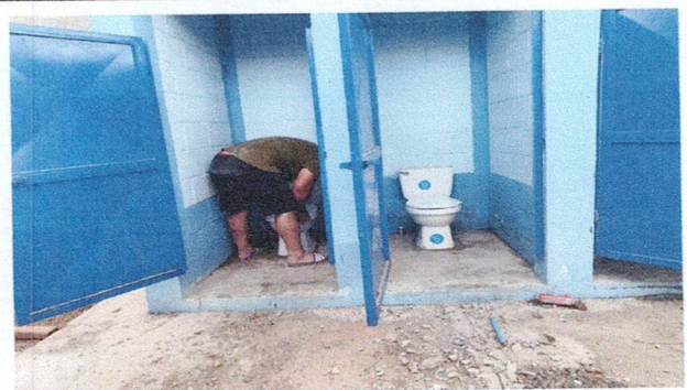
Foto 4: Reparación de Servicios Sanitarios
