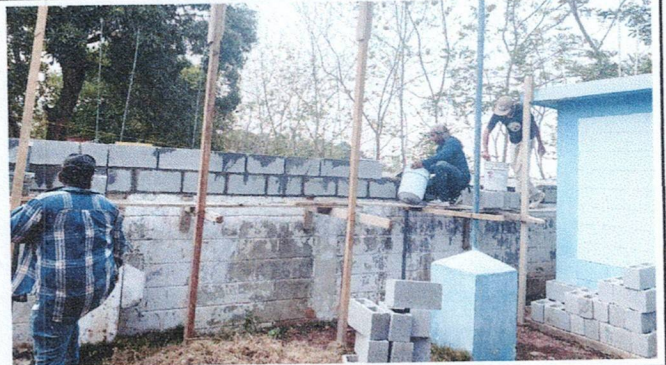
Foto 2: Reparación de muro perimetral
