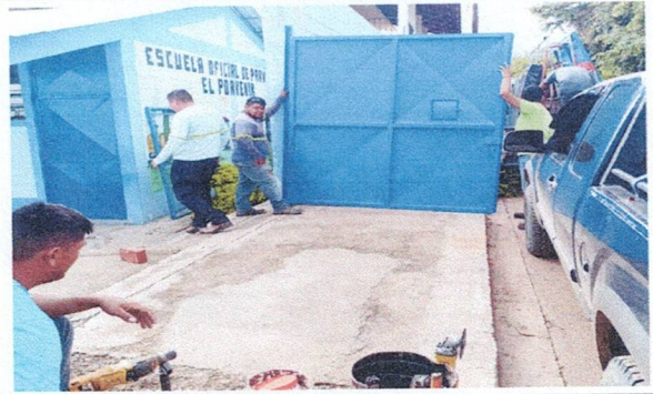
Foto 6: sustitución de porton de metal.
