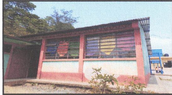
FOTO 3.3 Pintura en muros exteriores e interiores
