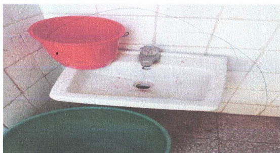
Foto 2.3 Sustitución de lavamanos
