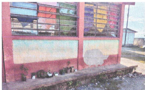
Foto 1.1 Ampliación de repello en aula
