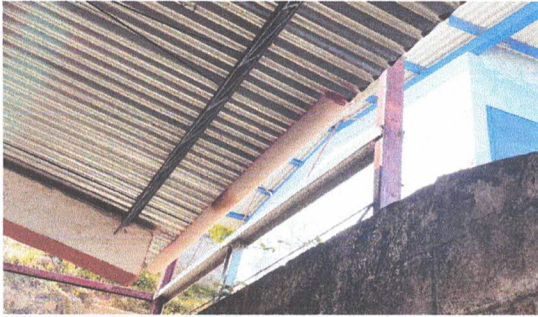
Foto 3:6 Sostitución de canal de pvc
