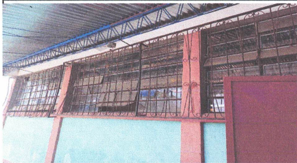
Foto 3:7 Sustitución de balcones de metal
