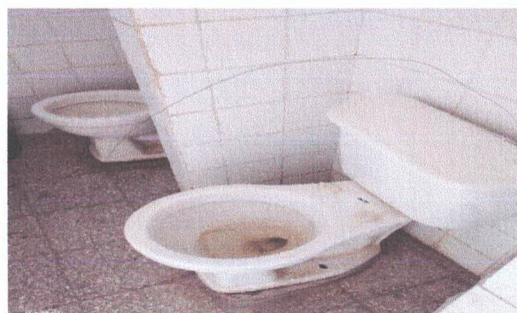
Foto 2.2 Sustitución de inodoros
