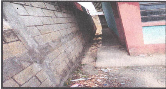
FOTO 3.4 Reparación de cuneta de concreto
