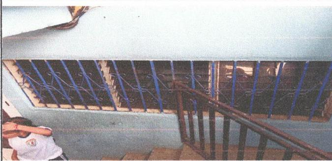
Foto 3 Sustitución de ventanas de estructura de metal y vidrio por ventanas de pvc reforzadas, vidrio y reticula
