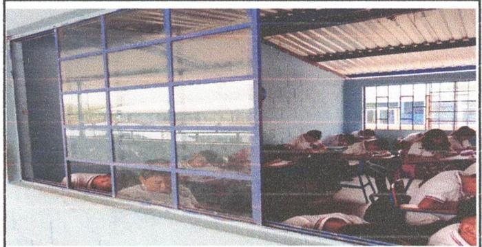
Foto 2: (2.1) Sustitución de ventanas de estructura de metal y vidrio por ventanas de pvc reforzadas, vidrio y reticula
