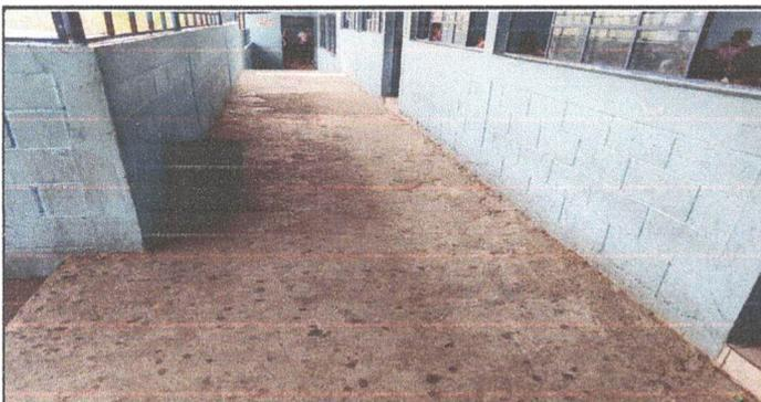
Foto 5: Instalación de Pido cerámico Incluyendo el material de pegamix psp.
