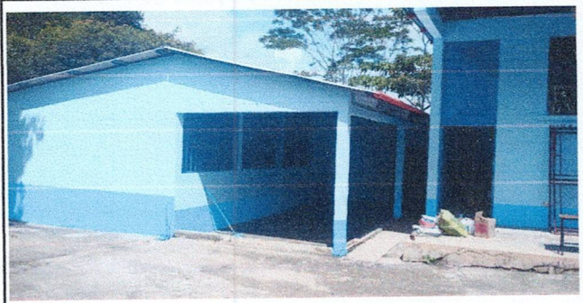
Foto1: Instalación y soprte de metal completo
