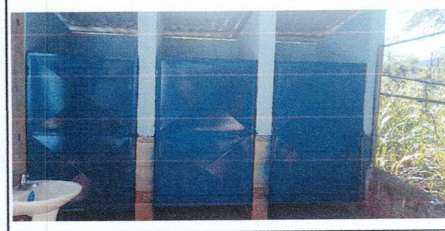
Foto 6: Instalación de Puertas
