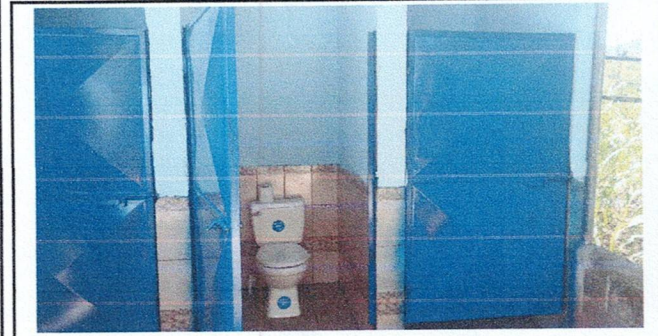
Foto 5: Instalación de Servicios Sanitarios
