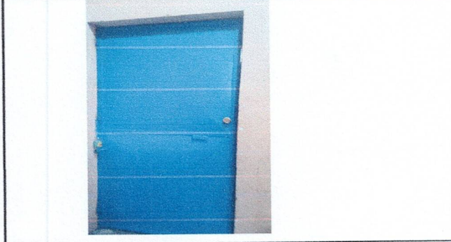
Foto 4: Mantenimiento de puertas
