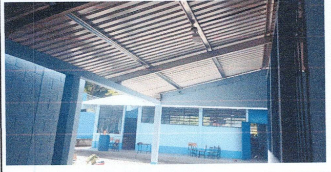
Foto 2: Instalación de lámina y sistema eléctrico
