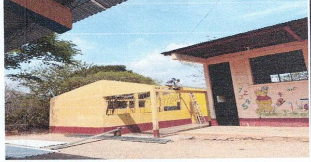
Foto 2: Instalación de cubierta de soporte de metal
