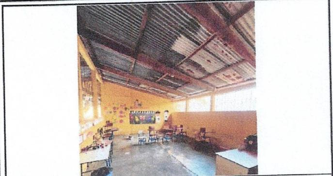
Foto 1: Reparación de cubierta de techo para Aulas, Dirección, Corredor y Bodega. Sustituyendo Tendales de madera por metal, lamina aluzinc troquelada calibre 26 legitimo y capote.
