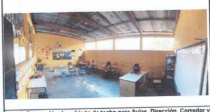
Foto 2: Reparación de cubierta de techo para Aulas, Dirección, Corredor y Bodega. Sustituyendo Tendales de madera por metal, lamina aluzinc troquelada calibre 26 legitimo y capote.
